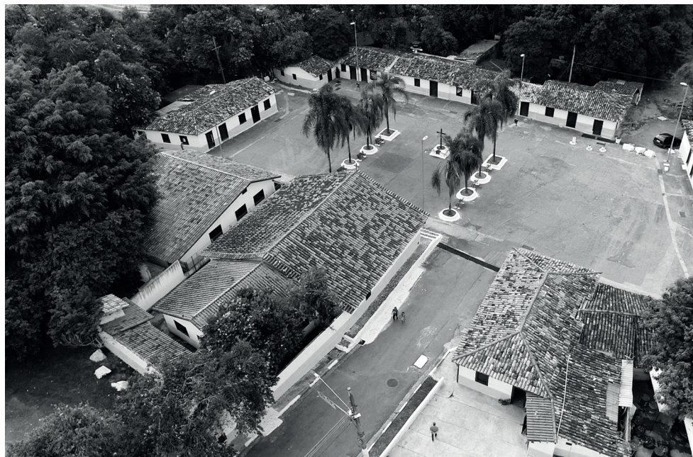
Aldeamento Jesuítico de Carapicuíba, Conjunto Arquitetônico e Urbanístico Tombado. Foto do acervo: Departamento de Comunicação de Carapicuíba.
