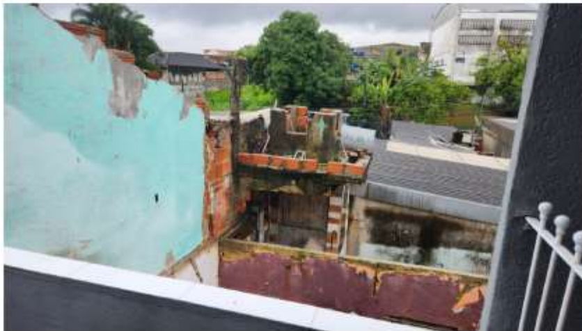
Figuras 4 e 5 – Fotos tiradas pelo corredor da casa nº 6 (vizinho da casa a ser demolida) - trecho da entrada do imóvel onde temos dois pavimentos (térreo + 1º pavimento).
