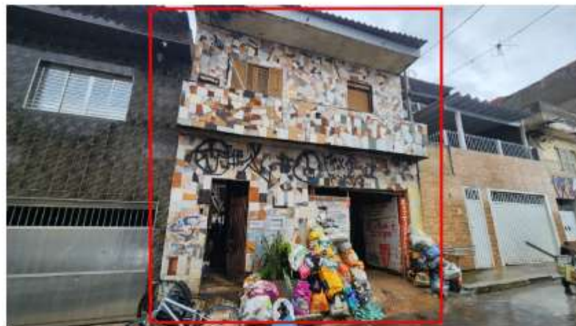
Figuras 2 e 3 – Fotos da fachada frontal do imóvel localizado na Rua Deraldo, 5 – Vila Dirce – Carapicuíba/SP. O imóvel em questão está interditado pela Defesa Civil e deverá ser demolido.
